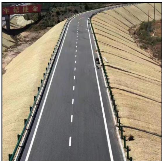
匝道植物纤维毯防护
