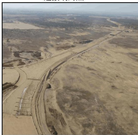
风沙区路基工程区
