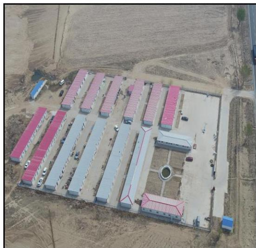
施工队项目部
