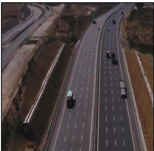
平台排水沟及边沟
