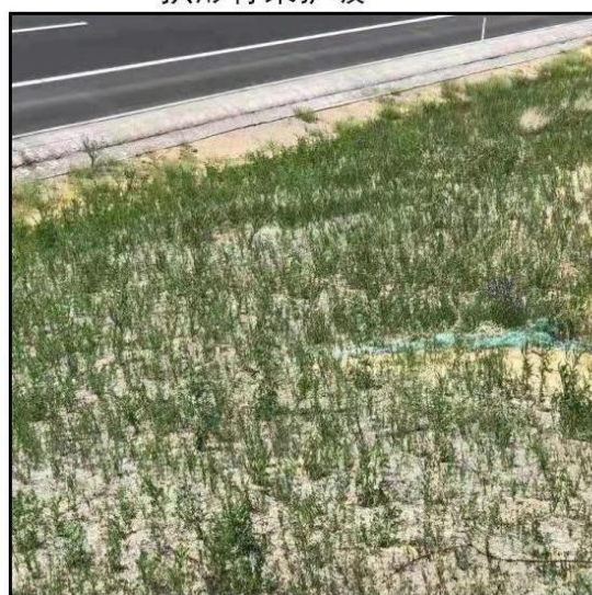
路堤植草防护
