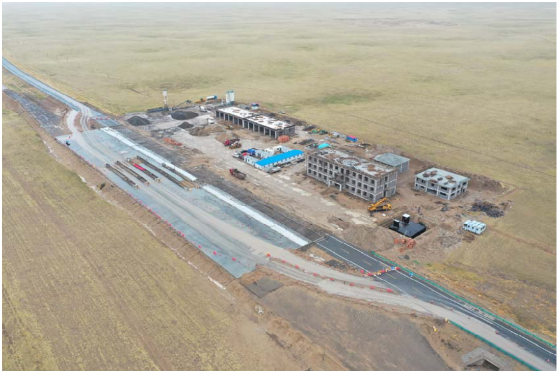
新址收费站建设现状（2023年6月）
