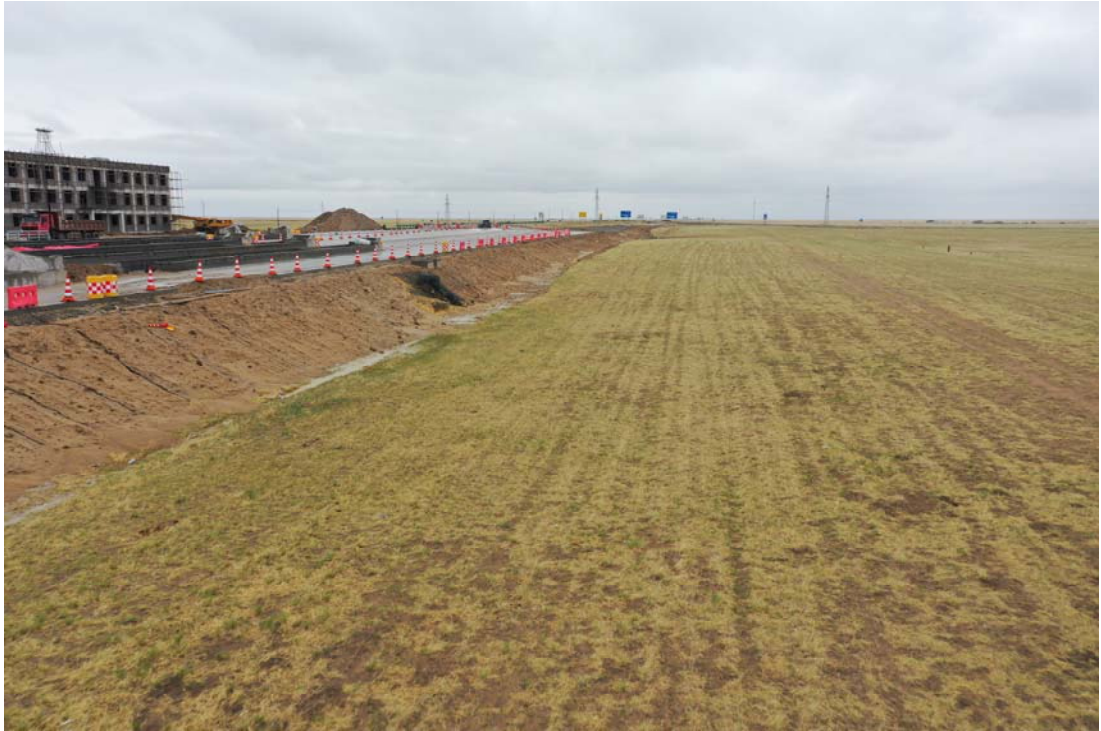
线路等宽段填方边坡
