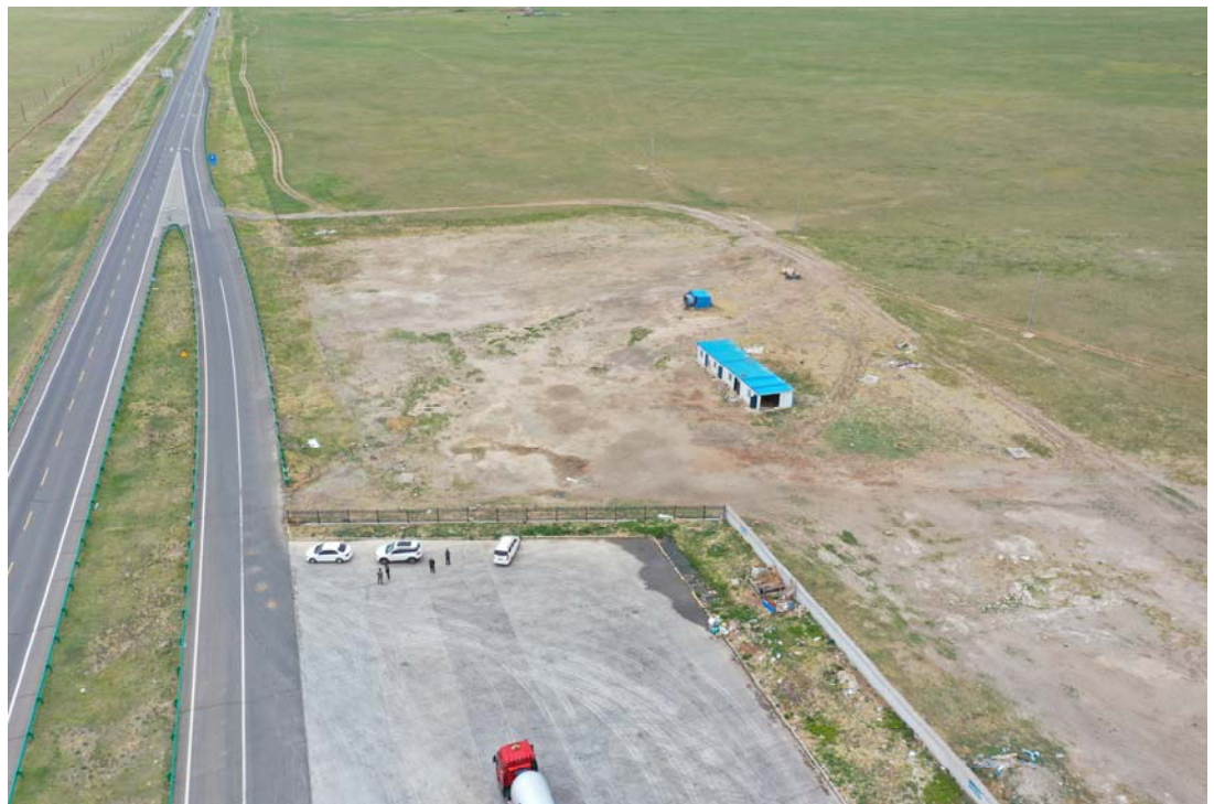
临时堆土场（甘珠尔庙停车区西侧）
