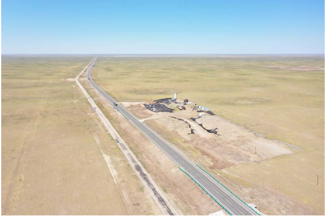
新址收费站建设现状（2022年9月）
